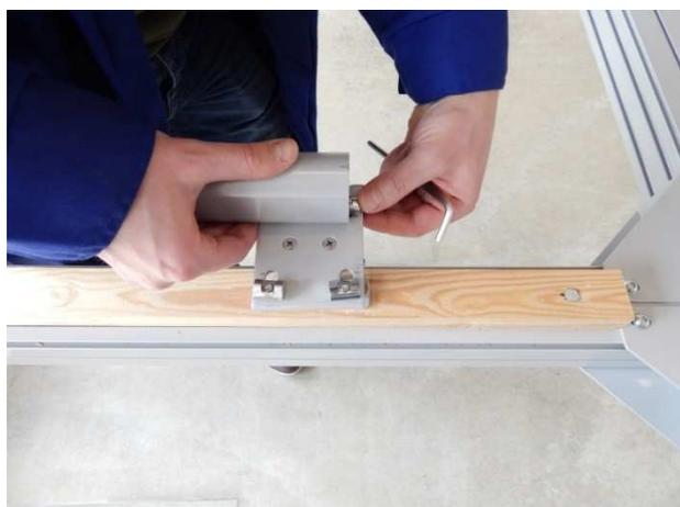
2. Bei modularer Montage schieben Sie die Führungsschiene über die Nutensteine und ziehen anschließend die Schrauben fest.
