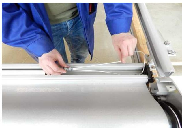
3. Ziehen Sie das Seil durch die Rollen in den Seitenkappen des Ausladeprofils.
