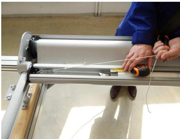
12. Spannen Sie analog zu Punkt 10 die Feder auf der anderen Seite des Ausladeprofils.
