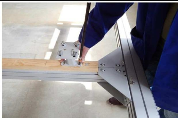
4. Im Falle einer modularen Montage, bringen Sie den modularen Halter zw. den Systemen an.
