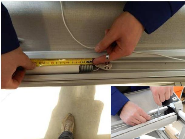
11. Spannen Sie die Feder gemäß der Information auf der Federabdeckung und ziehen anschließend die Schrauben der Seilblockade fest.
