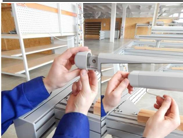
17. Bringen Sie die Endkappen an den Führungsschienen an und schrauben sie fest.
