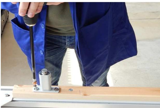
3. Bringen Sie die Führungsschienehalter mit entsprechendem Befestigungsmaterial fest am Untergrund an.
