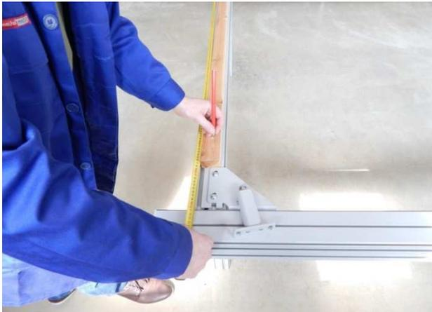
1. Bestimmen und Markieren Sie die Position der Führungsschienehalter (Anzahl abhängig von der Systemgröße).
